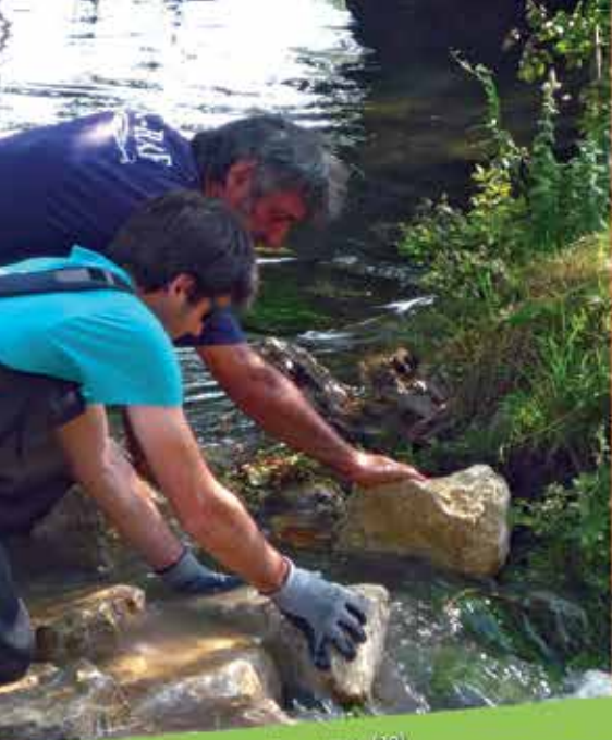
Travaux de restauration du Pamproux (79)
