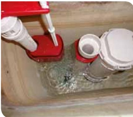
faut dévisser l'écrou central du mécanisme. Vous pouvez maintenant changer le joint et le remonter, en le positionnant de manière correcte.
