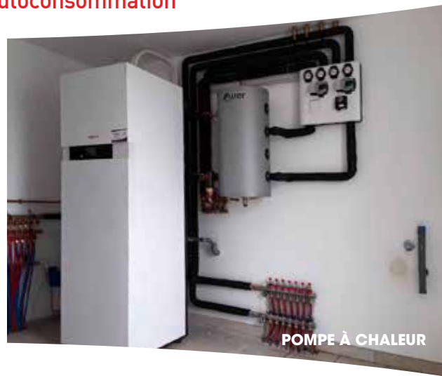
BATTERIES DE STOCKAGE
