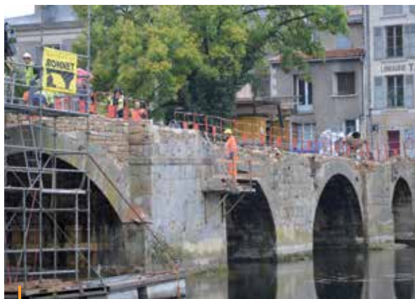
Grand Poitiers a confié les travaux à l'entreprise Bonnet. La phase de démolition s'est terminée fin octobre. S'engage la reprise de maçonnerie des tympans. Signe particulier : la petite chapelle protestante, côté boulevard Bajon, sera remplacée par un belvédère avec un lutrin explicatif.
