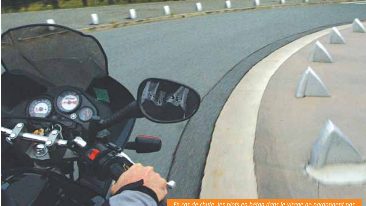
En cas de chute, les plots en béton dans le virage ne pardonnent pas
